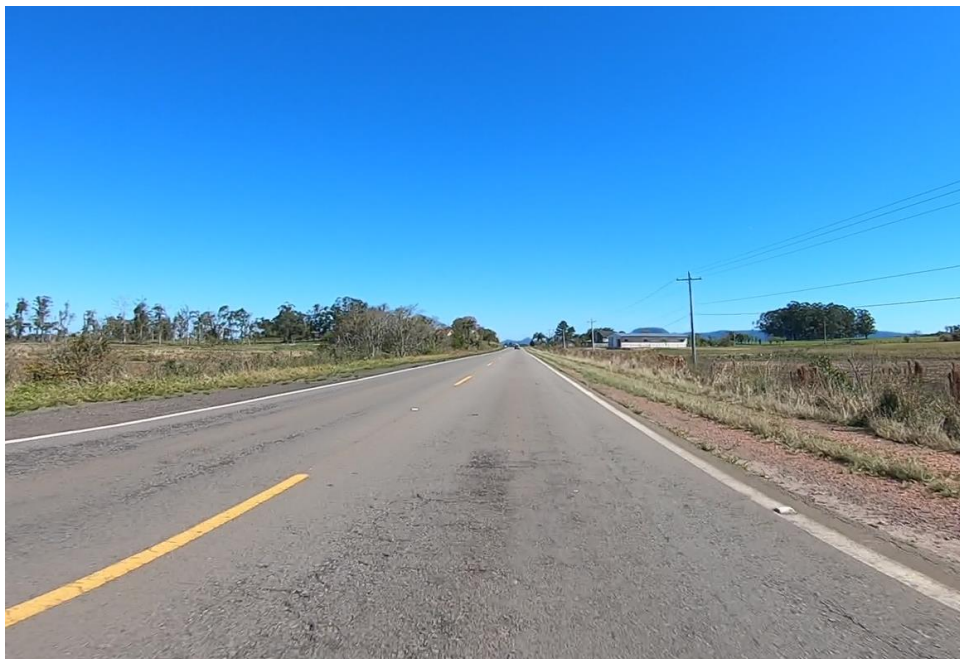
Defeitos diversos – captura de imagem extraída de vídeo-registro da rodovia realizado em 31/08/2021
