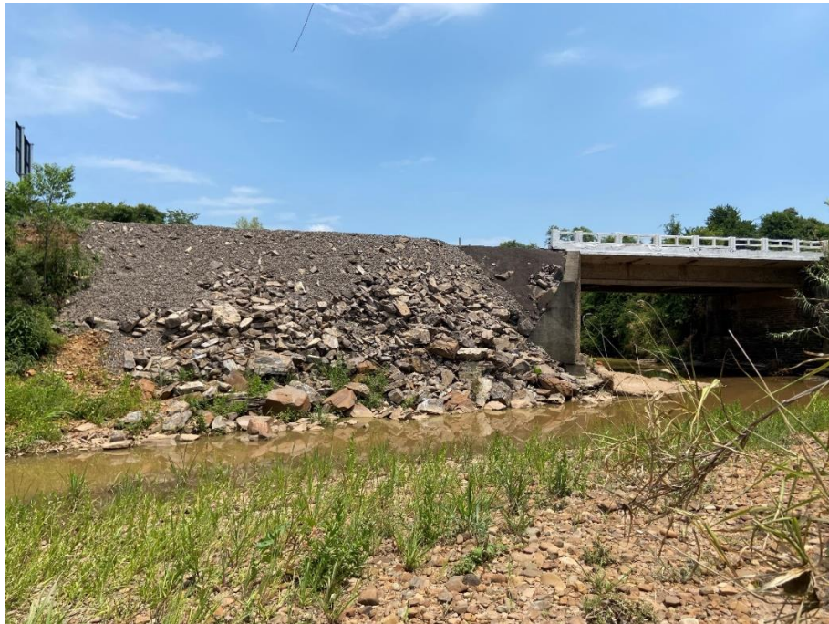
Figura 6 - Foto panorâmica do ponto, mostrando talude ala.
