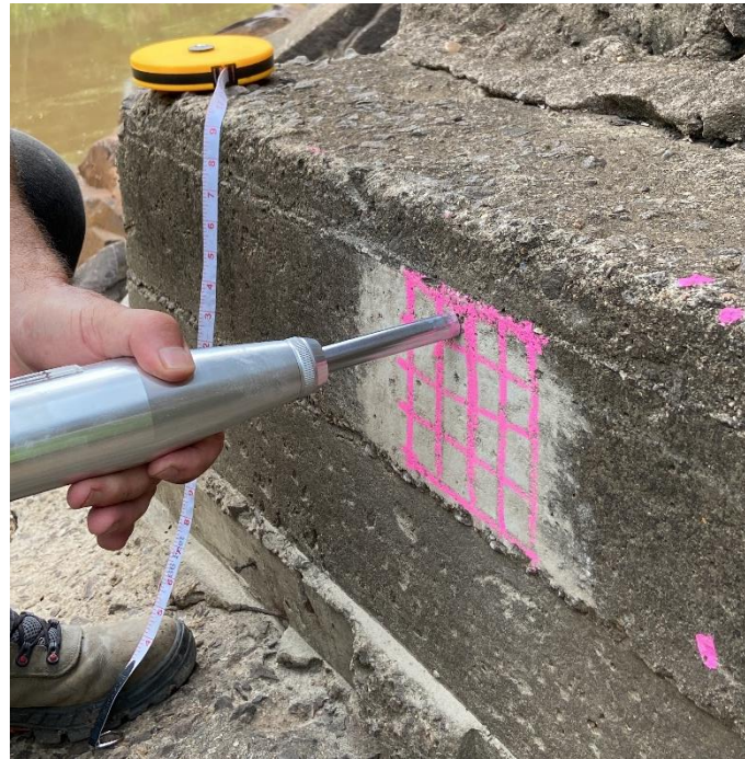
Figura 10 - Ensaio Esclerométrico na viga inferior da ala da ponte.
