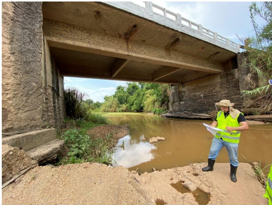
Figura 5 - Foto do ponto mostrando a ala tombada e a ponte.
