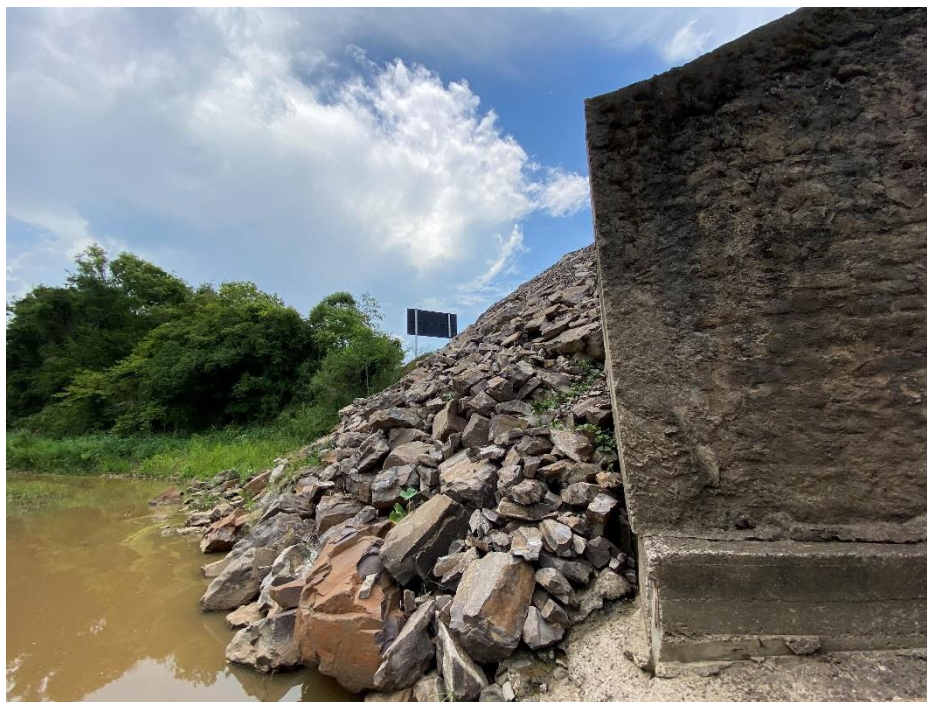
Figura 9 – Destaque para o talude de enrocamento lançado.
