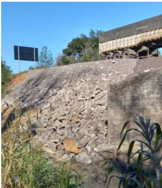
Recomposição pontual e superficial do pavimento e enrocamento do terrapleno
