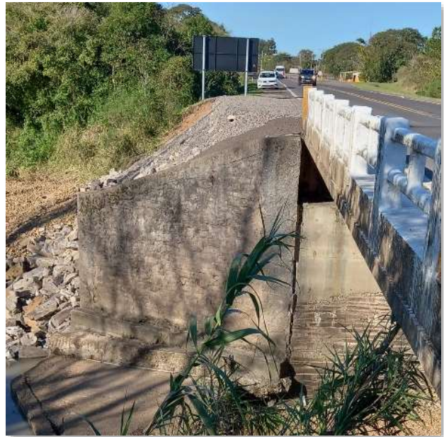
Recomposição pontual e superficial do pavimento e enrocamento do terrapleno
