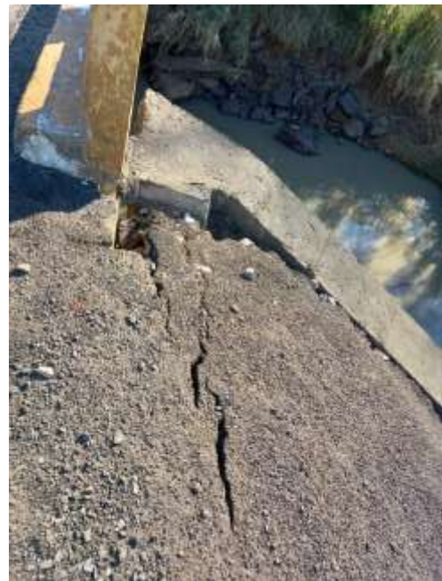
Recomposição pontual e superficial do pavimento e enrocamento do terrapleno
