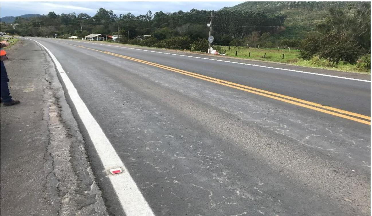
**Figura 6:** Trecho com intervenção da EGR em **março/2021** (km 32+800) e apresentando Reflexão de Trincas e Bombeamento de finos.
