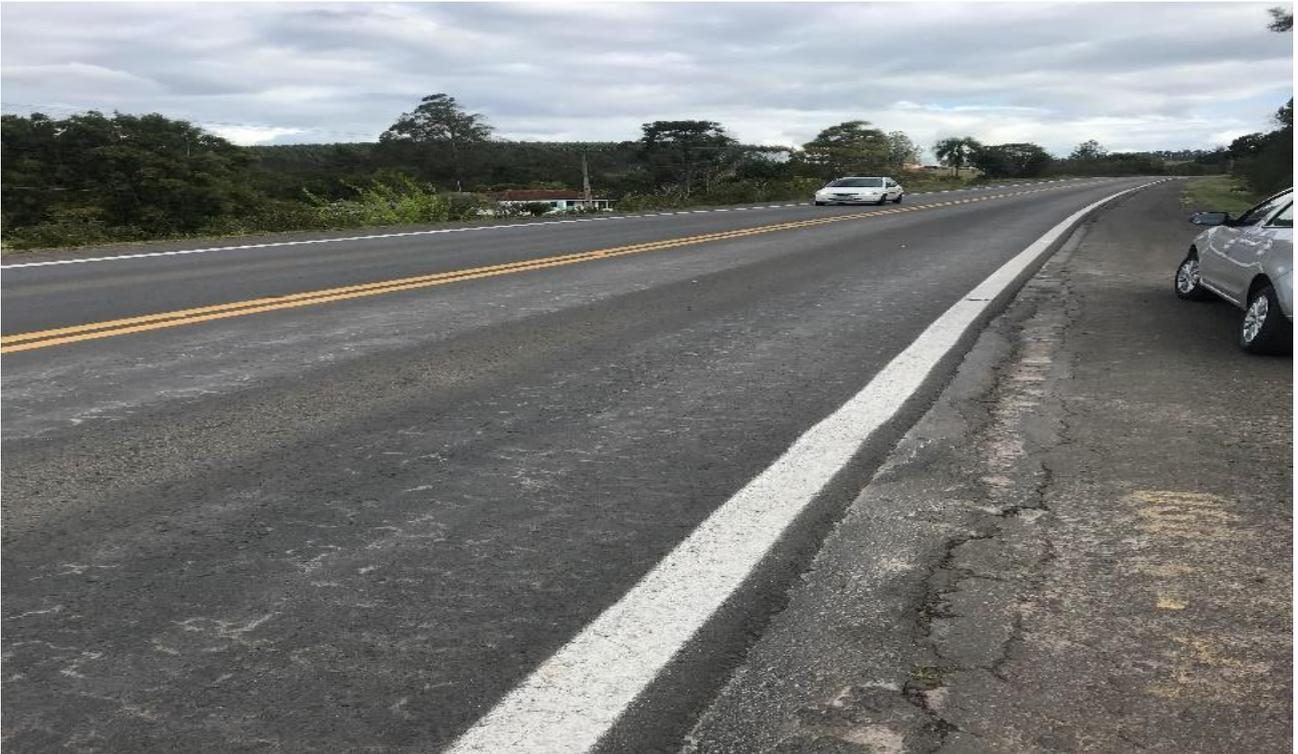
**Figura 5:** Trecho com intervenção da EGR em **março/2021** (km 32+770) e apresentando Reflexão de Trincas e Bombeamento de finos.
