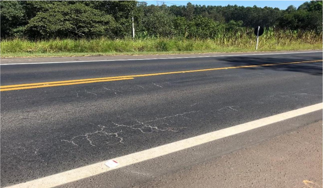
**Figura 7:** Trecho com intervenção da EGR em **março/2021** (km 35+300) e apresentando Reflexão de Trincas e Bombeamento de finos.
