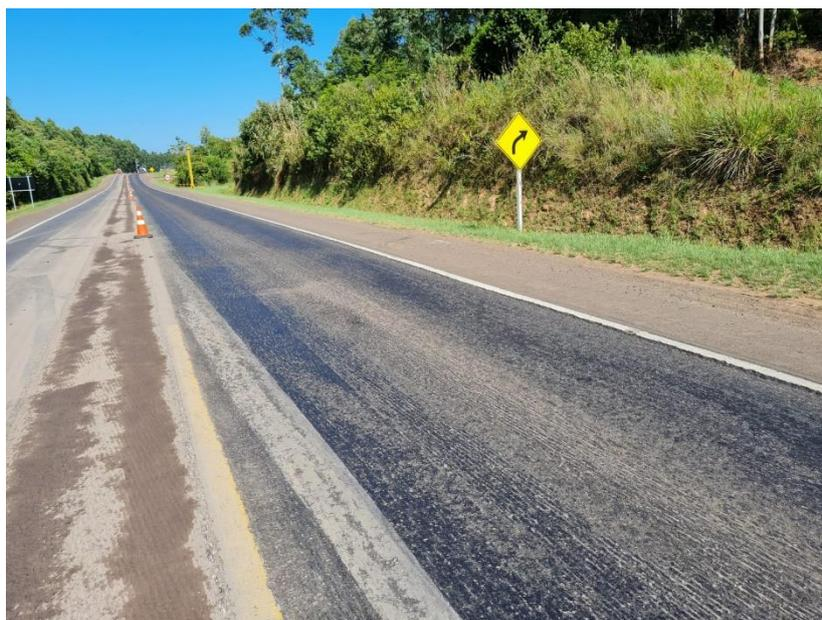
**Figura 20** – Superfície Exsudada após a execução da microfresagem
