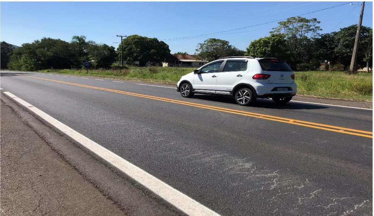
**Figura 4:** Trecho com intervenção da EGR em **março/2021** (km 31+550) e apresentando Reflexão de Trincas e Bombeamento de finos
