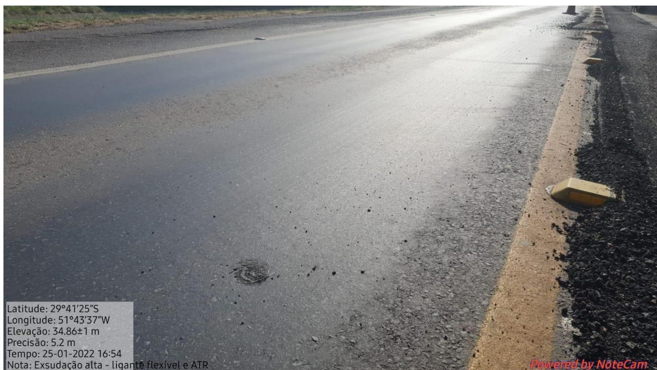
**Figura 19** – Superfície Exsudada antes da aplicação do microrrevestimento
