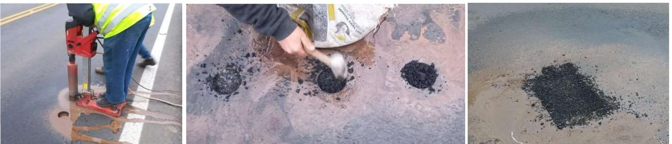
**CPS COM IDENTIFICAÇÃO DA MARCA DE CORTE COM SERRA PARA EXTRAÇÃO DE CAMADA INFERIOR**
