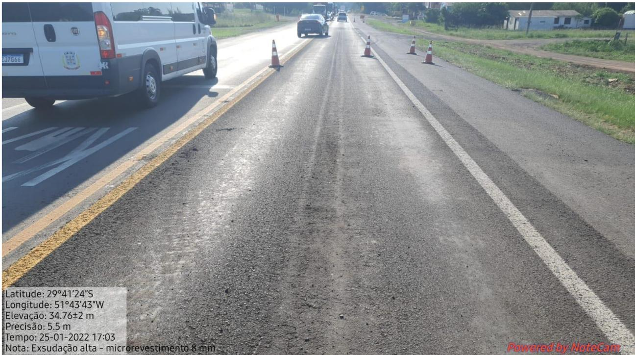
**Figura 20** – Superfície Exsudada após a aplicação do microrrevestimento
