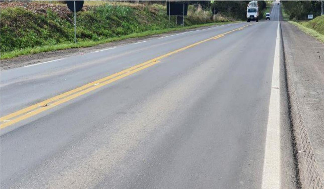
**Figura 11:** Trecho com intervenção da EGR em **fevereiro/2021** (km 77+760) e apresentando Afundamento nas Trilhas de Roda
