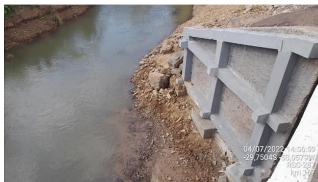
Figura 4 - km 167+860 Depois (Julho/2022)
