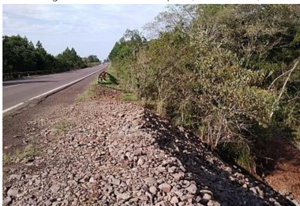
Figura 3 - km 172+992 Depois (Julho/2022)
