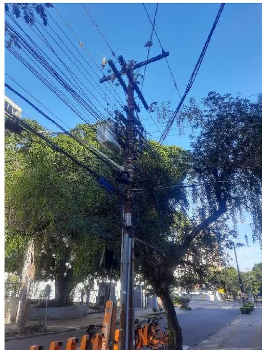
(Foto B) Vegetação em contato com rede de BT, MT e equipamentos. [R. Visc. do Herval, 1092, 30/07/23]
