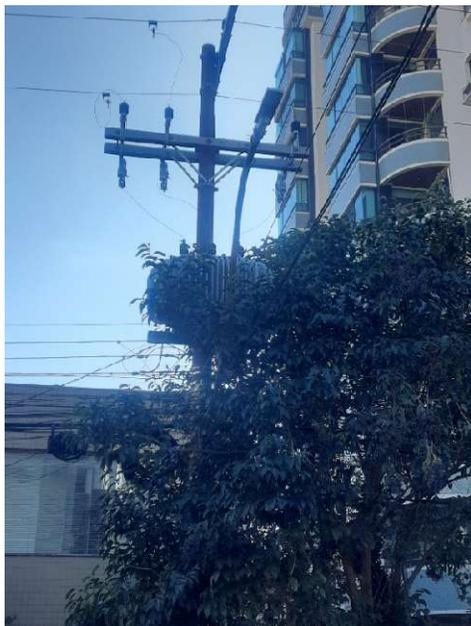
(Foto G) Vegetação em contato com equipamento.
