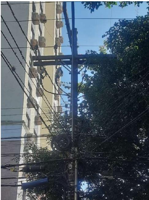
(Foto E) Vegetação em contato com a rede. [R. Visc. do Herval, 970, 30/07/23]
