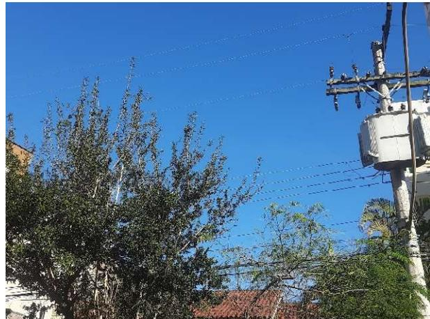
(Foto F) Rede de BT atravessando copa de árvore e galhos tocando na rede de MT. [TR 2261-6]
