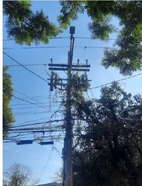
(Foto D) Vegetação em contato com equipamento. [R. Visc. do Herval, 982, 30/07/23]
