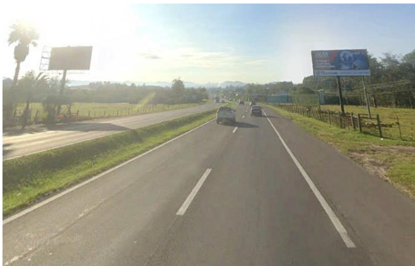
Figura 14 – ERS-239, canteiro central de 4m.
