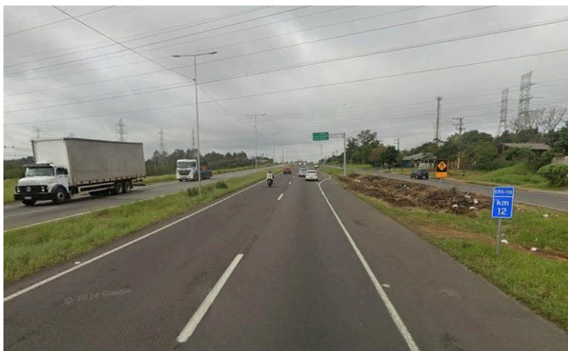
Figura 13 – ERS-118, canteiro central de 4m.
