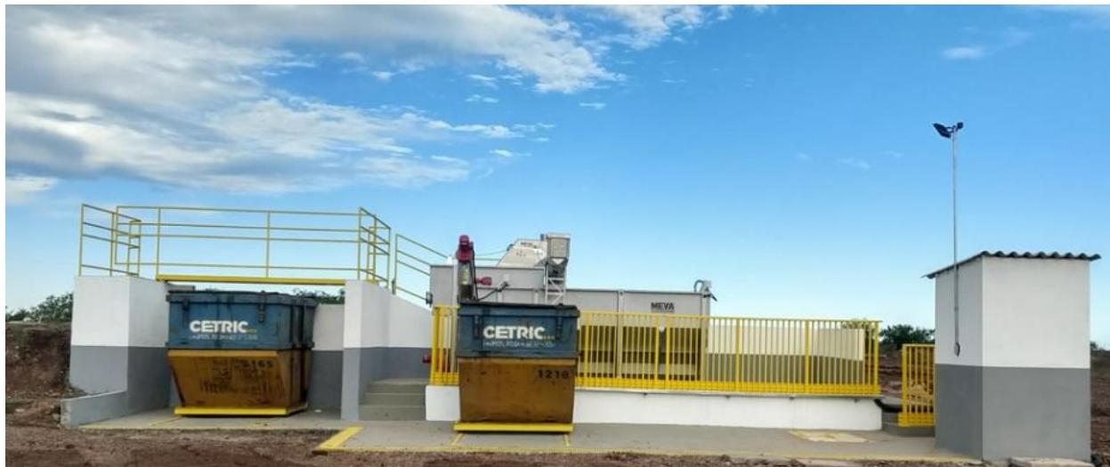
Figura 1- Estação Compacta para recebimento de efluentes coletados através de caminhões limpa-fossas.
