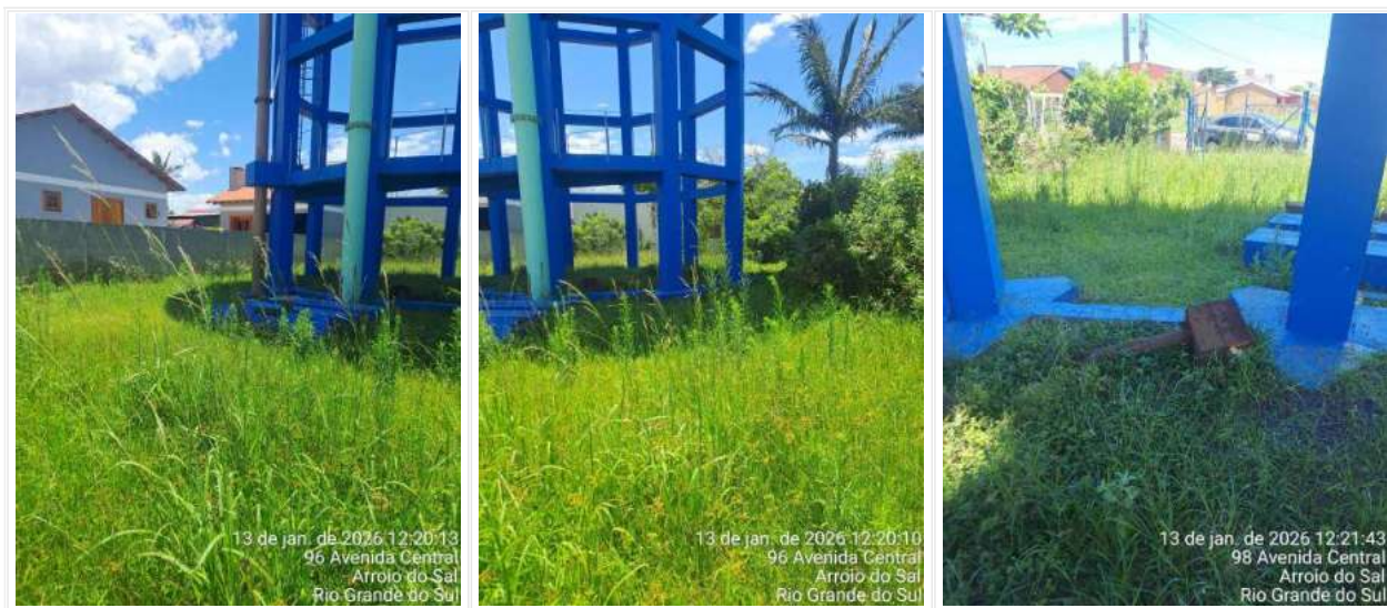
Figura 18 - Tubulações do Reservatório R2
