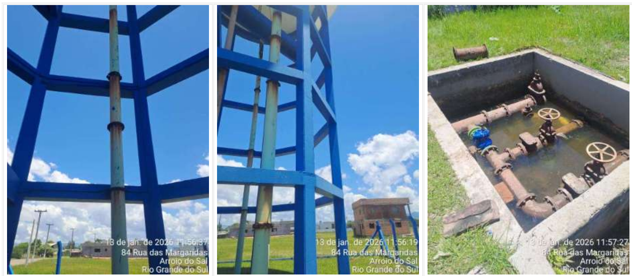
Figura 16 - Sistema de distribuição do Reservatório R2
