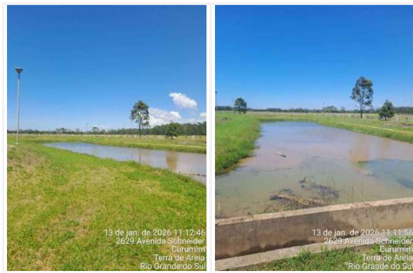
Figura 8 - Tanques de evaporação da ETA II
