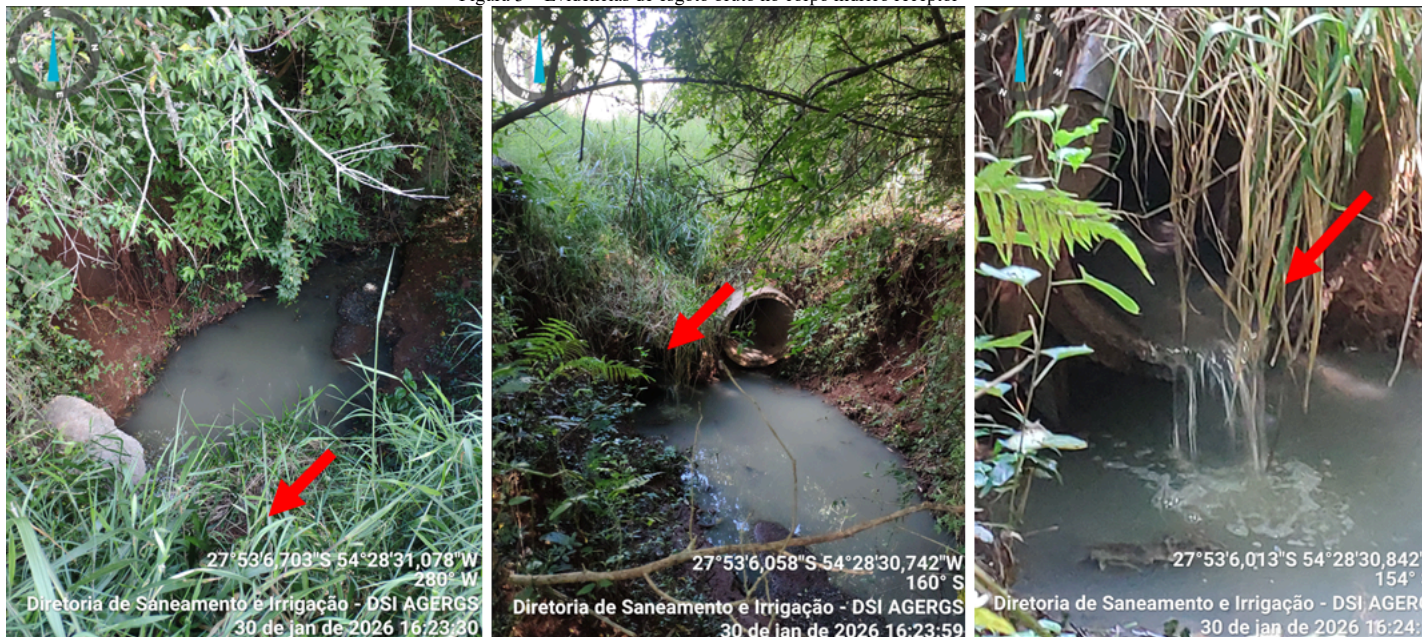
Figura 3 – Evidências de esgoto bruto no corpo hídrico receptor
