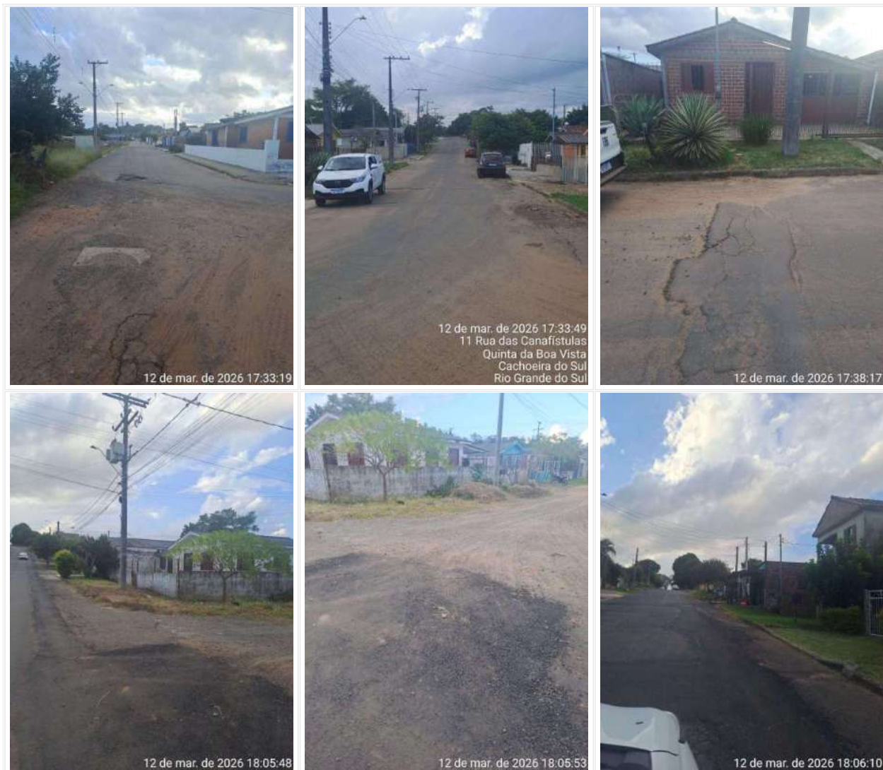
Figura 32 - Repavimentação Rua das Canafistulas
