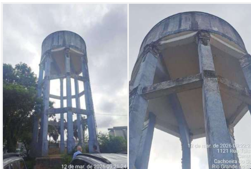
Figura 23 - Estrutura do Reservatório R11
