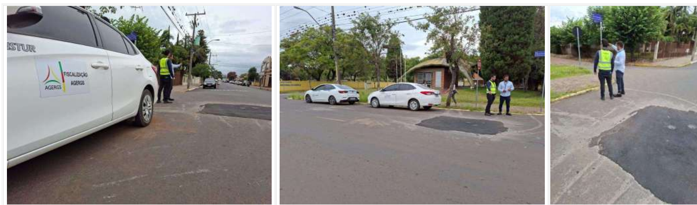
Figura 33 - Repavimentação Rua Conde de Porto Alegre
