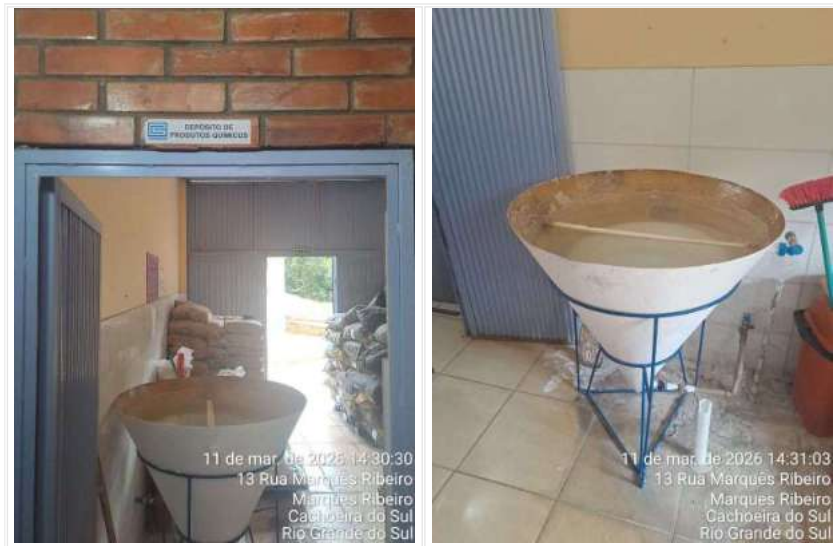
Figura 12 - Equipamento obsoleto de dosagem de fluoreto
