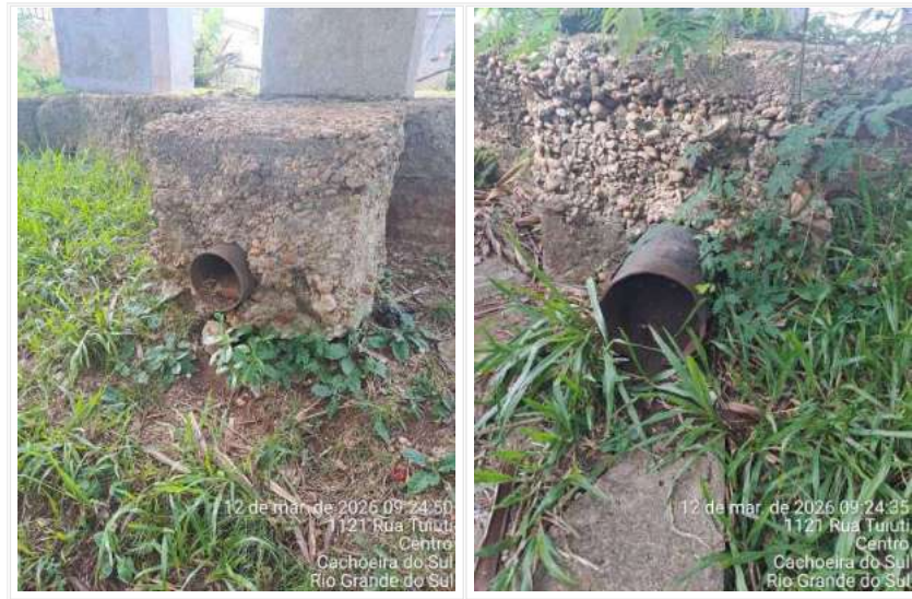
Figura 25 - Extravasor obstruído
