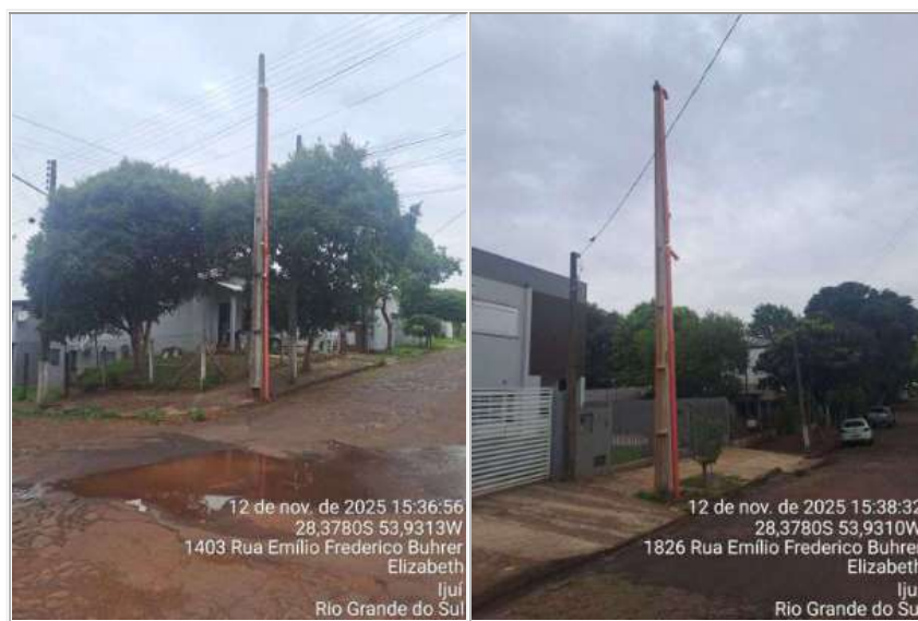
Figura 23 - Dissipadores de odor
