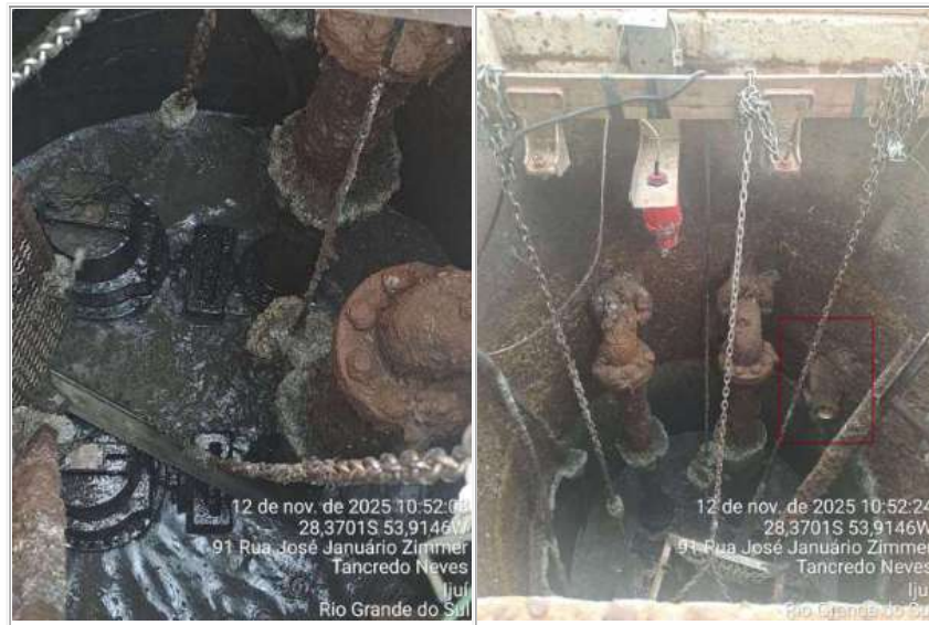
Figura 11 - EBE Júlio Taube com indícios de extravasamentos
