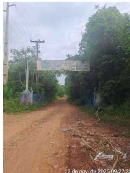
Figura 2 - Placa de identificação da ETE
