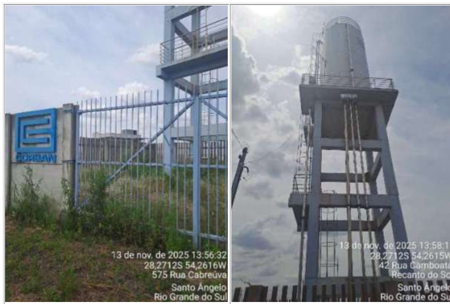
Figura 24 - Reservatório Reserva das Missões
