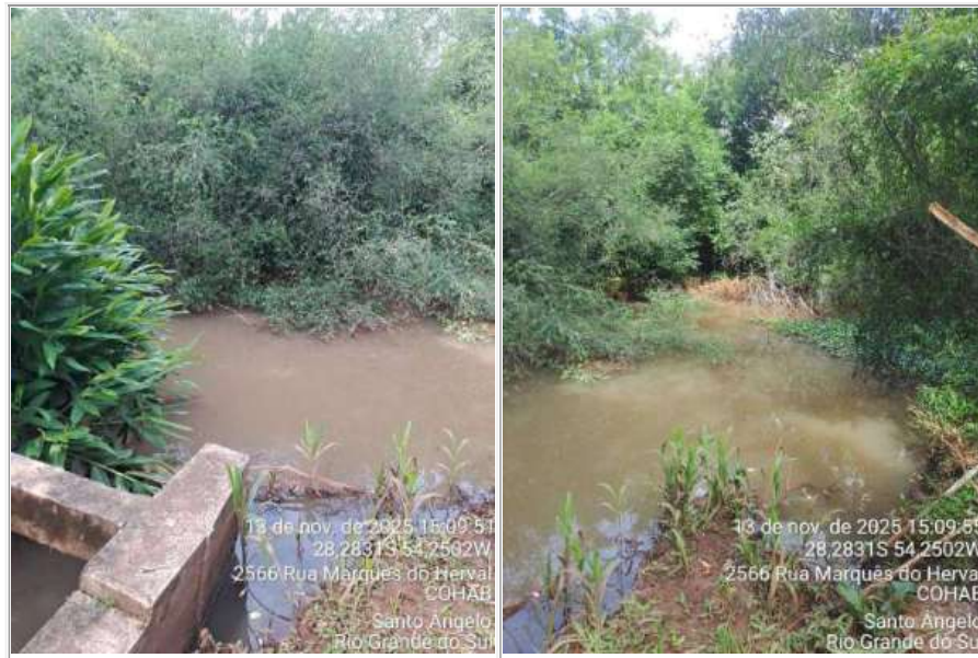
Figura 7 - Tomada d'água da Captação do Rio Itaquerintim.
