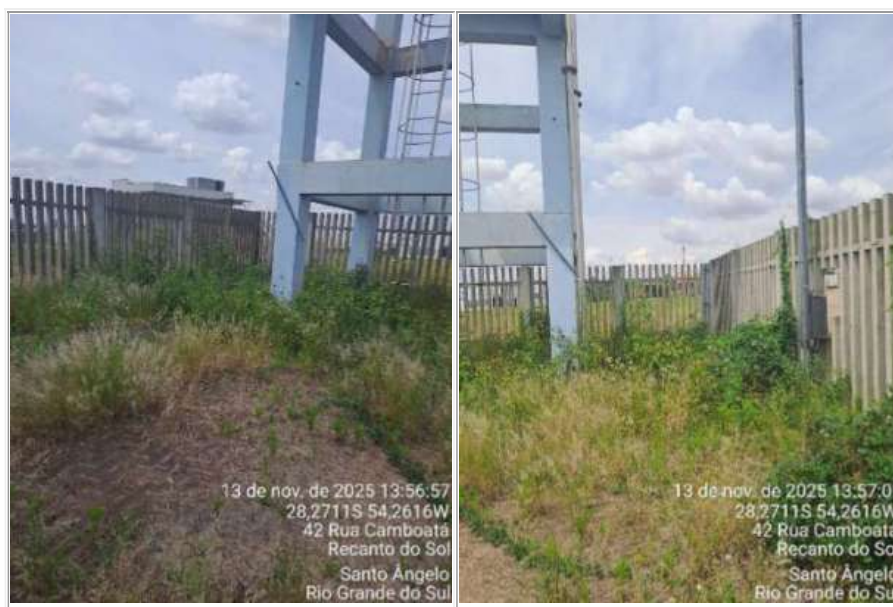
Figura 25 - Acesso ao Reservatório Reserva das Missões
