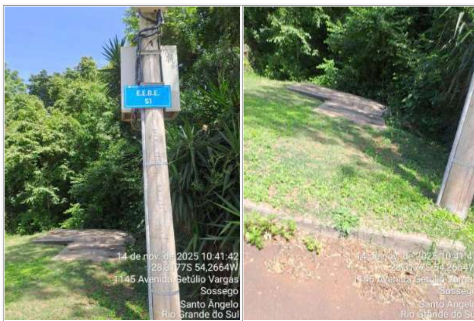
Figura 3 - Acesso à EBE Jardim Sabo 2.
