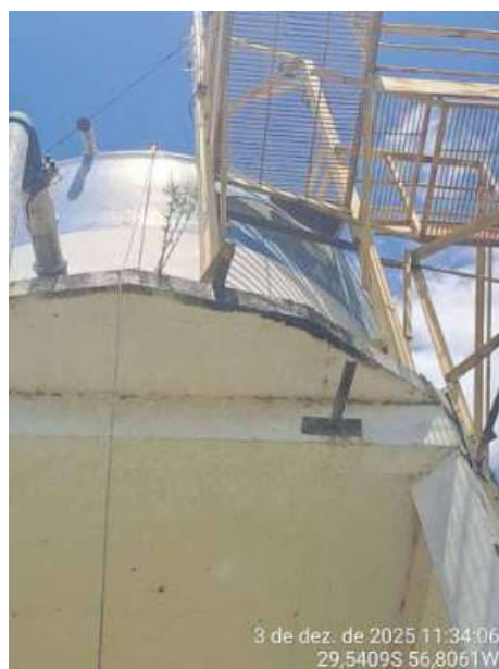
Figura 15 - Extravasor do Reservatório Barragem Sanchuri
