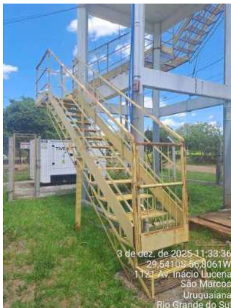
Figura 13 - Escadas de acesso ao Reservatório Barragem Sanchuri
