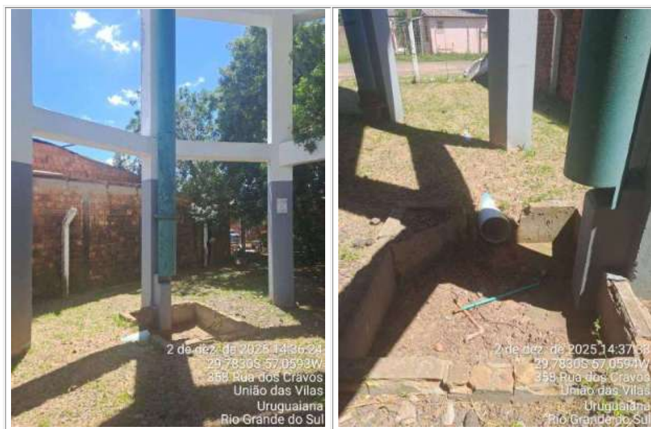
Figura 11 - Extravasor do Reservatório Promorar (Elevado)
