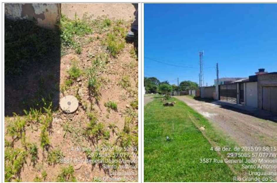
Figura 9 - Rua General João Manoel - Residências contempladas com rede de esgotamento sanitário
