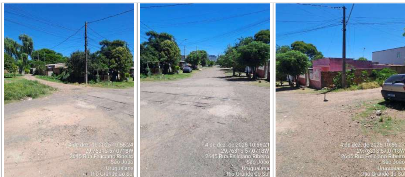
Figura 13 - Rua Feliciano Ribeiro - Residências contempladas com rede de esgotamento sanitário
