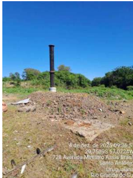
Figura 2 - Poço da EEEB 06
