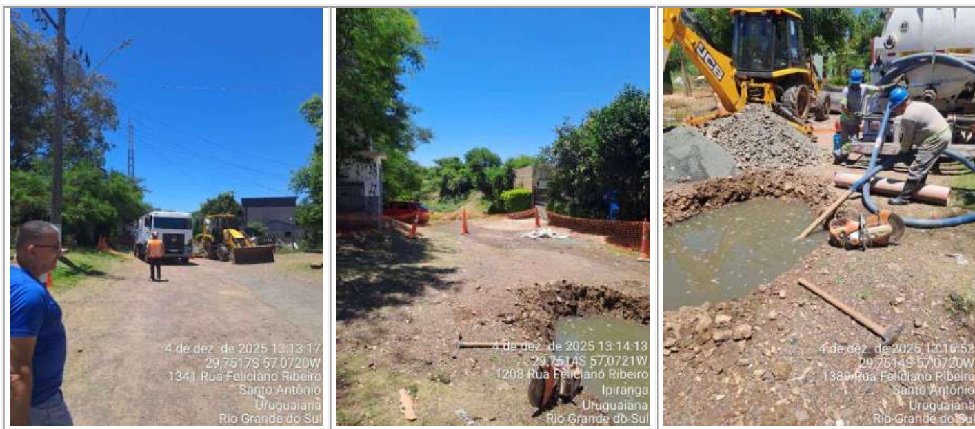
Figura 7 - Equipe de esgoto efetuando os reparos na rede.
