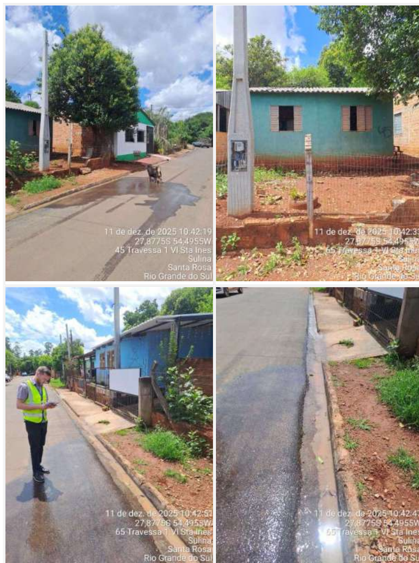
Figura 33 - Vazamento na rede de água (Travessa 1, nº 45, Bairro Vila Santa Inês)
