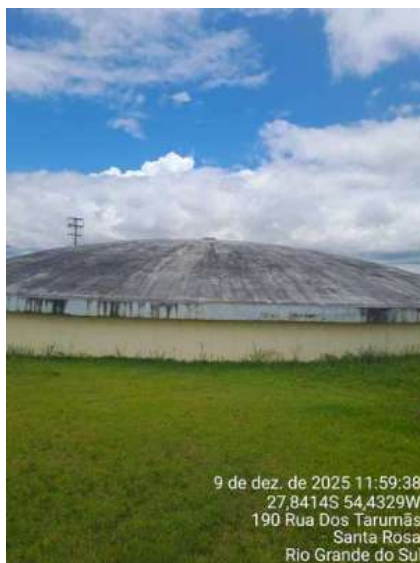
Figura 26 - Estrutura do Reservatório R1A da ETA II (Semienterrado)
