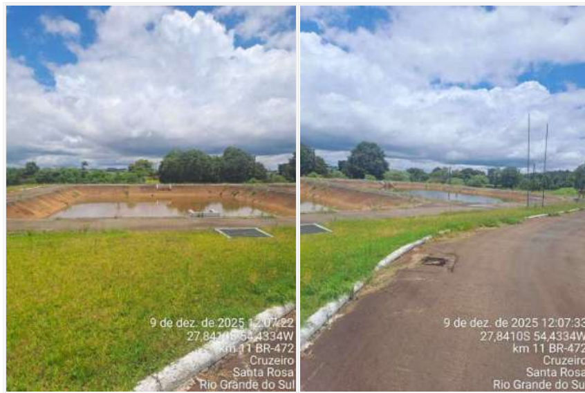
Figura 13 - Tanques de evaporação da ETA II
