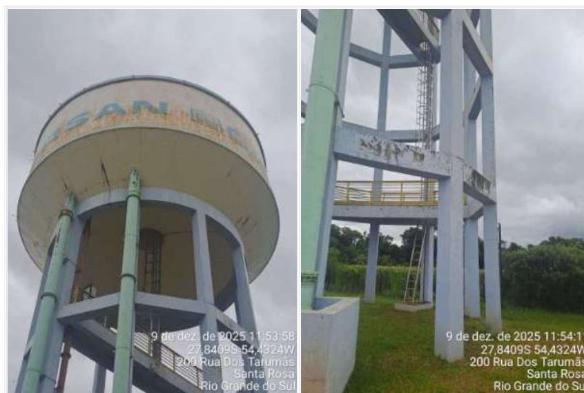
Figura 26 - Estruturas do Reservatório da ETA II (Elevado)
