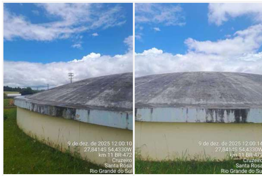
Figura 26 - Pintura do reservatório R1A da ETA II (Semienterrado)
