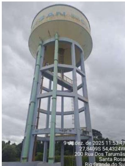
Figura 26 - Reservatório da ETA II (Elevado)
