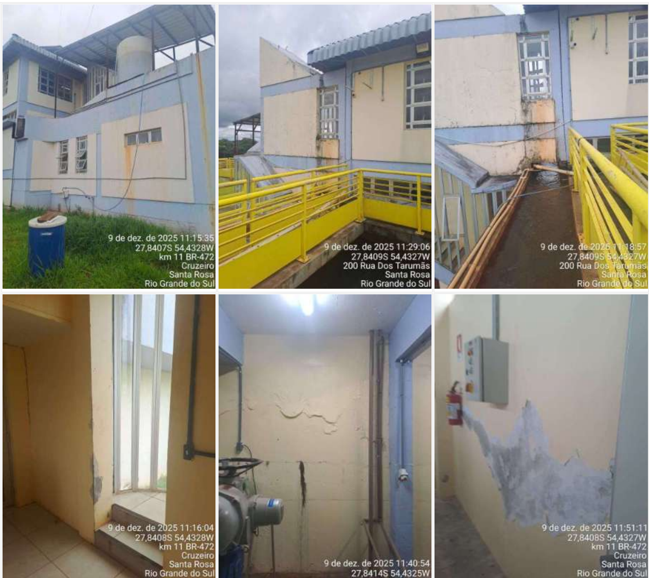
Figura 16 - Estruturas da ETA II
