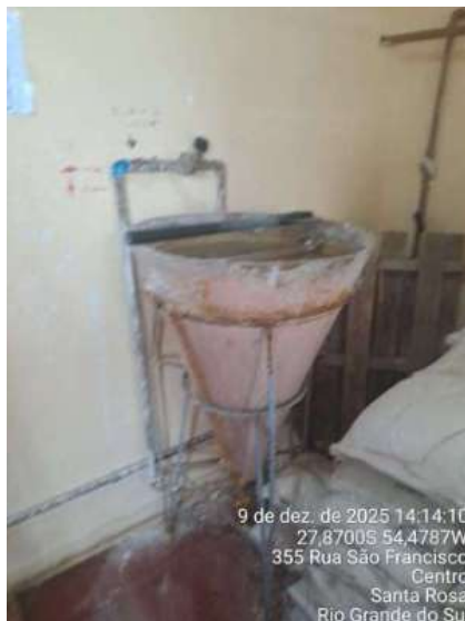
Figura 22 - Dosagem de flúor na ETA I
