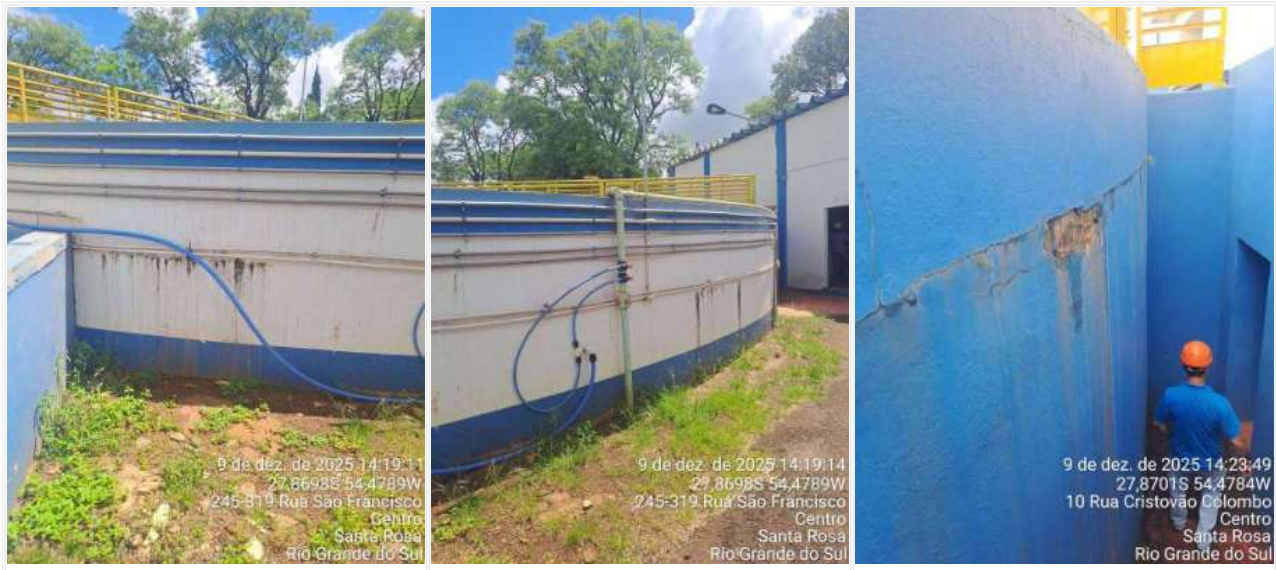
Figura 23 - Estruturas da ETA I
