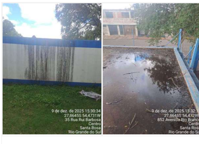
Figura 29 - Estruturas do Reservatório R2B (Semienterrado)
