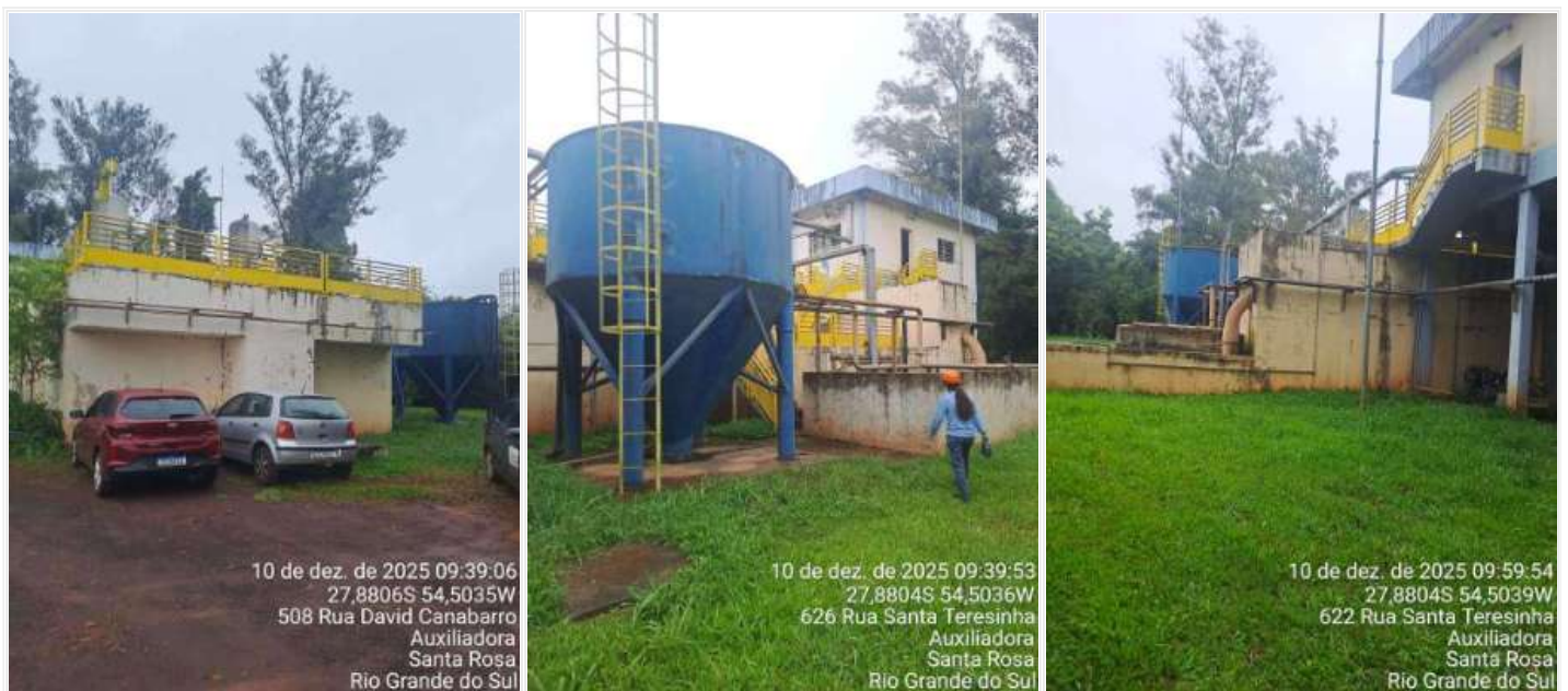
Figura 3 - Pintura da ETE Santa Rosa
