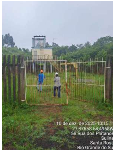
Figura 7 - Portão de acesso à EBE Santa Inês
