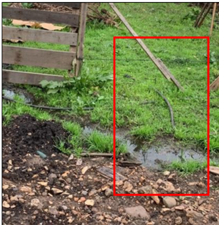
Figura 9- Rua Miguel Beleza, Cidade Nova- Julho/2023.
