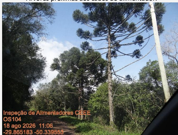
Árvores próximas aos cabos do alimentador.
