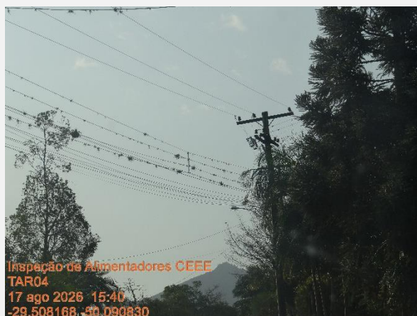
Cabos de BT tomados por vegetação.
