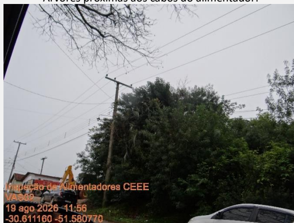
Árvores próximas aos cabos do alimentador.
