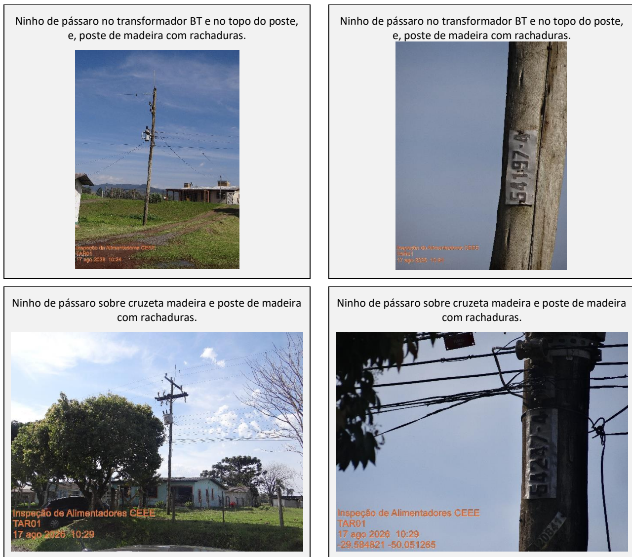
Figura 6 - Registro fotográfico da inspeção em campo do alimentador TAR01, realizada em 17/08/2026.
