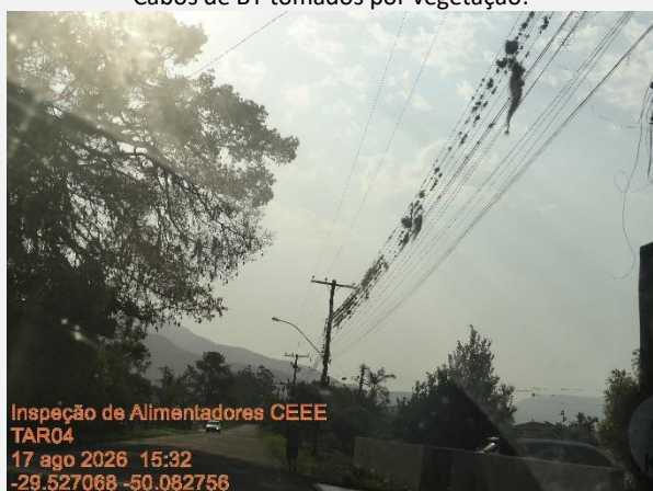
Cabos de BT tomados por vegetação.
