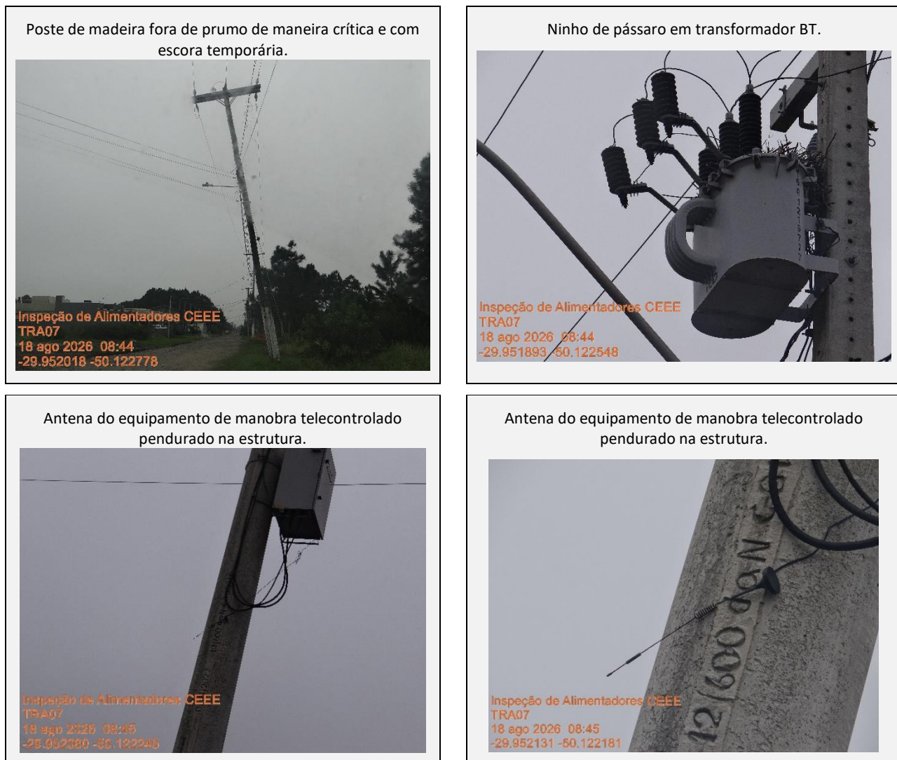
Figura 9 - Registro fotográfico da inspeção em campo do alimentador TRA07, realizada em 18/08/2026.
