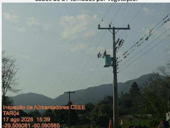
Cabos de BT tomados por vegetação.
