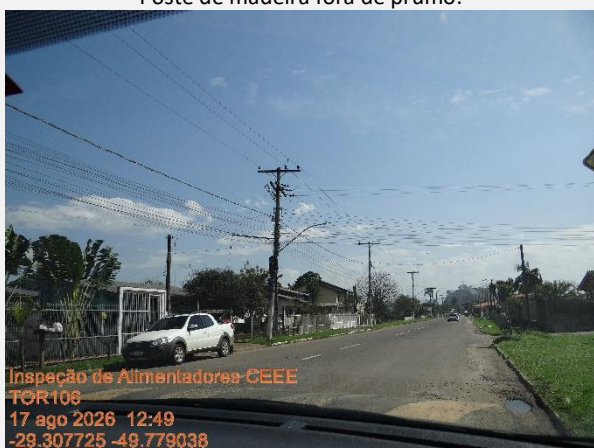
Poste de madeira fora de prumo.
