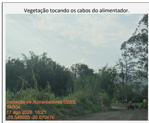
Figura 8 - Registro fotográfico da inspeção em campo do alimentador TAR04, realizada em 17/08/2026.
