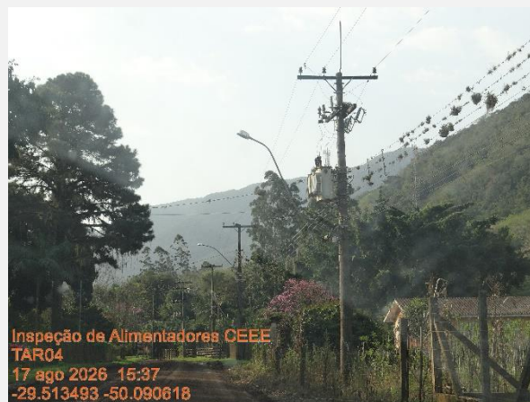
Cabos de BT tomados por vegetação.
