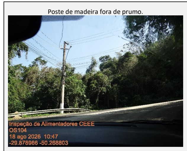
Figura 13 - Registro fotográfico da inspeção em campo do alimentador OS104, realizada em 18/08/2026.
