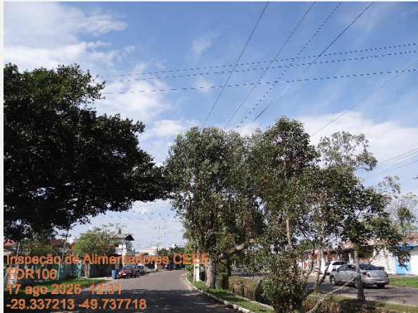
Vegetação próxima ao alimentador.
