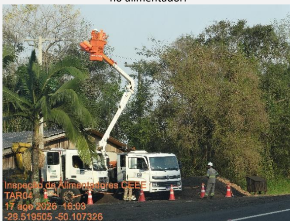
Equipe terceirizada da concessionária realizando intervenção no alimentador.
