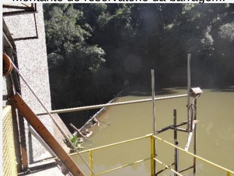
Montante do reservatório da barragem.
