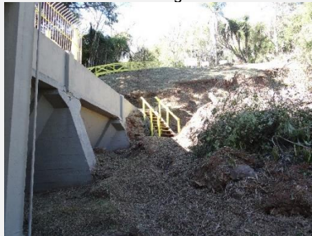
Pintura e conservação de escada de acesso na barragem.
