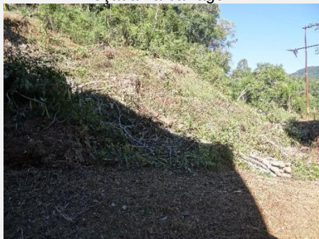
Roçada na barragem.
