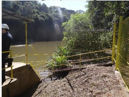
Conservação e pintura de portão e sinalização de segurança na barragem.
