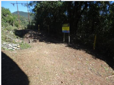
Roçada e sinalização de segurança na barragem.
