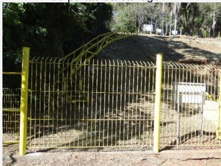
Conservação e pintura da escada de acesso e do portão da barragem.
