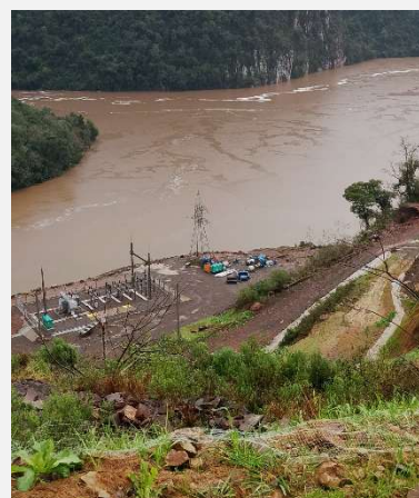
Acesso à Subestação Elétrica recuperado.
