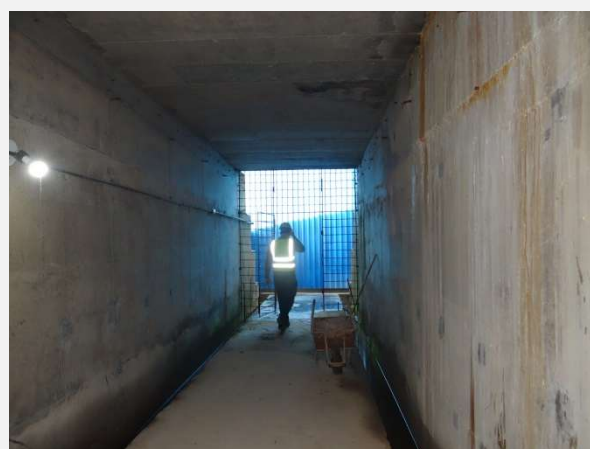
Galeria de Drenagem da Barragem da PCH Cachoeira Cinco Veados.
