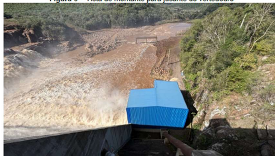
Figura 6 – Vista de montante para jusante do vertedouro
