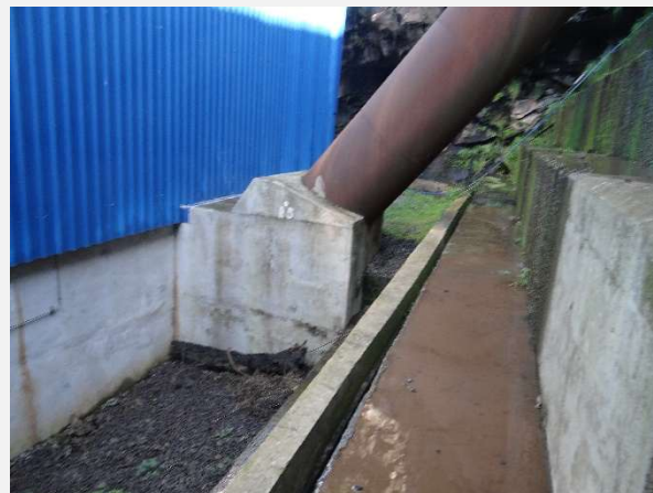
Tubulação de Adução e de Vazão Sanitária da PCH Cachoeira Cinco Veados.
