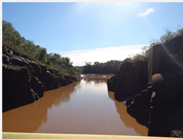
Canal de Adução da PCH Quebra Dentes.
