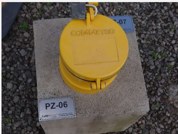
Instrumentação – piezômetro na Barragem margem esquerda da PCH Rincão São Miguel.
