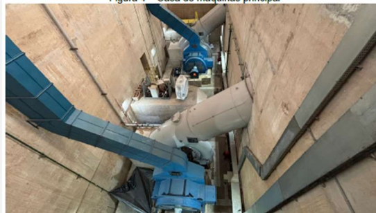
Figura 4 – Casa de máquinas principal
