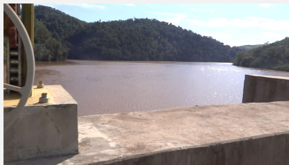
Reservatório da PCH Cachoeira Cinco Veados.
