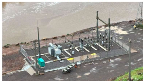
Figura 5 – Recuperação da subestação
