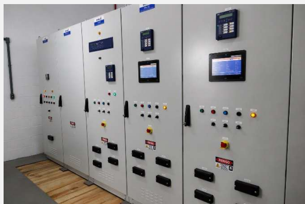
Sala de cubículos recuperada.
