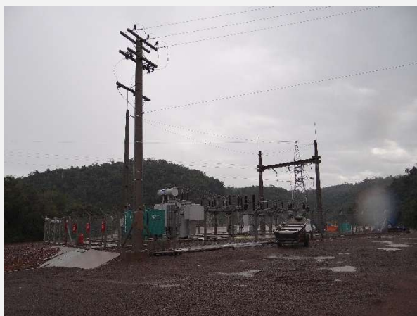
Recuperação da Subestação Elétrica da PCH.
