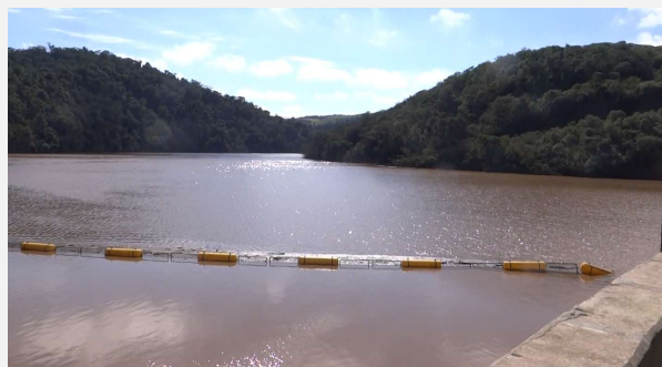
Reservatório da PCH Cachoeira Cinco Veados.
