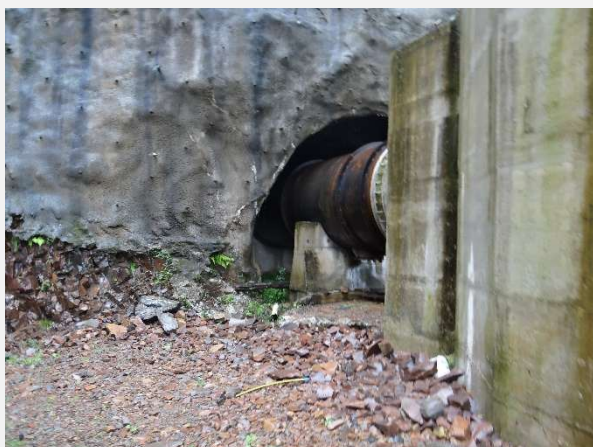
Fechamento do conduto metálico que foi aberto para manutenção do túnel de adução junto à chaminé de equilíbrio da PCH Salto do Guassupi, por onde passou a água no evento de junho de 2025.
