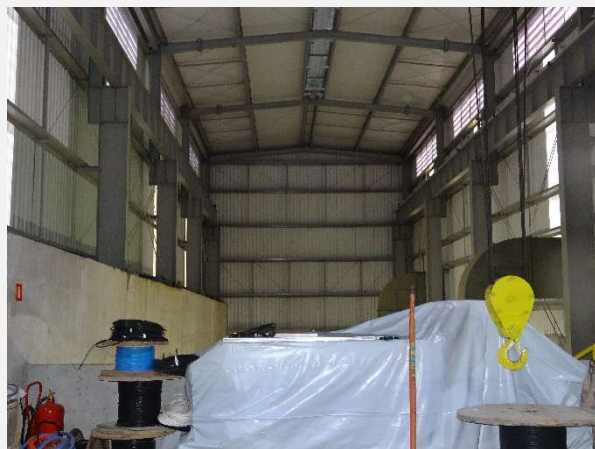
Material carreado retirado do interior da Casa de Força.
