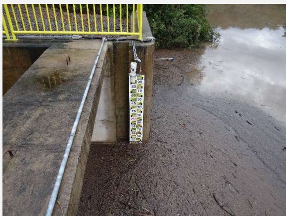
Recuperação da tomada d'água túnel de acesso.
