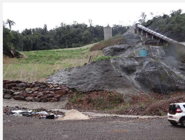
Talude junto a Casa de Força recuperado.
