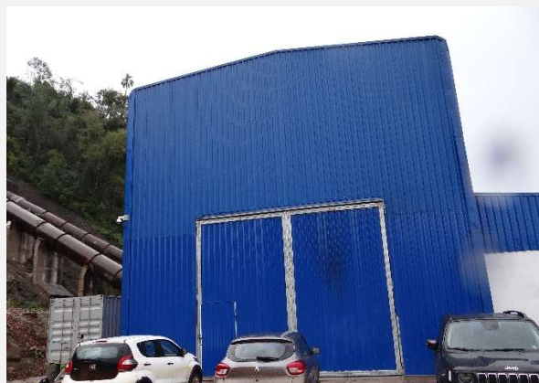
Detritos e material carreado do deslocamento de terra retirados da Casa de Força.
