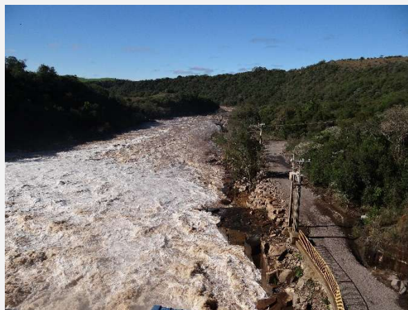
Jusante da Barragem da PCH Quebra Dentes.
