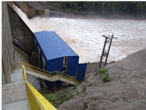
Acesso a casa de força secundária, destruído pela queda do guindaste, recuperado.
