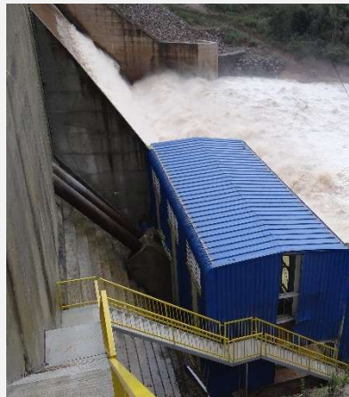
Conduto forçados para casa de máquina auxiliar a jusante.
