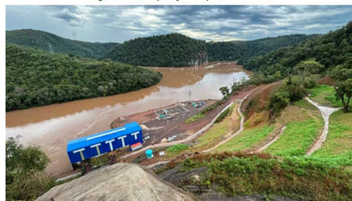
Figura 6 – Recuperação do pátio e do talude
