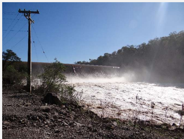
Jusante da Barragem da PCH Quebra Dentes.
