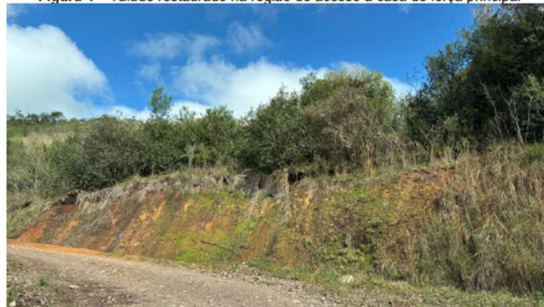
Figura 4 – Talude restaurado na região de acesso a casa de força principal
