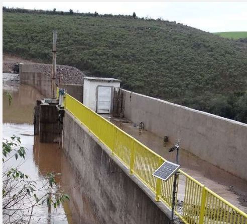
Descarga de fundo montante da barragem - onde está passando a vazão sanitária.
