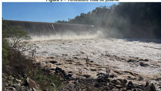
Figura 3 – Vertedouro vista de jusante
