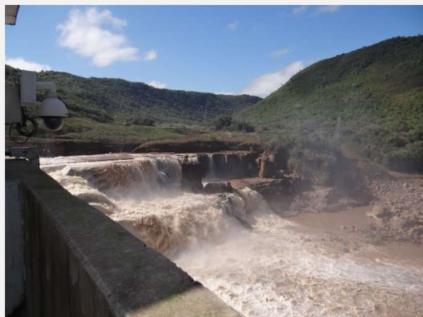
Jusante da Barragem da Cachoeira Cinco Veados.
