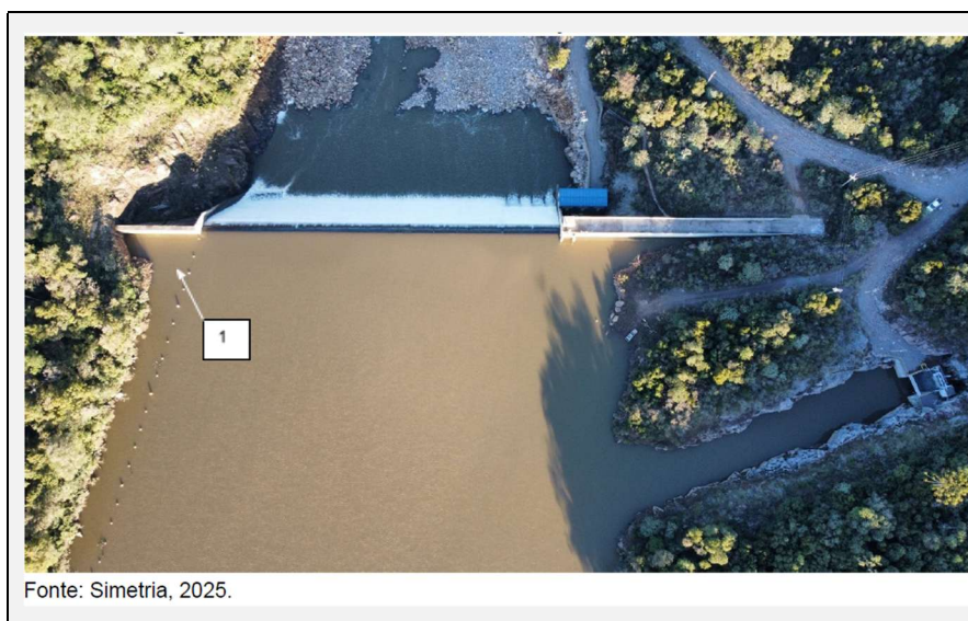
Figura 5 - Reservatório da PCH Quebra Dentes.
