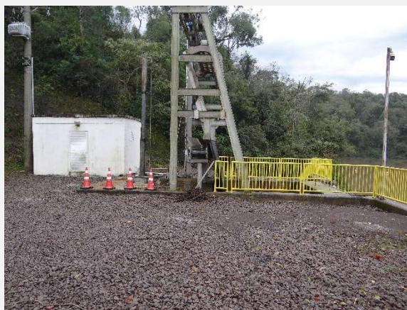
Recuperação da tomada d'água túnel de acesso.
