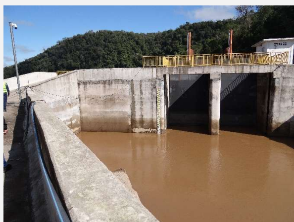
Comportas de Tomada D'água da PCH Cachoeira Cinco Veados.
