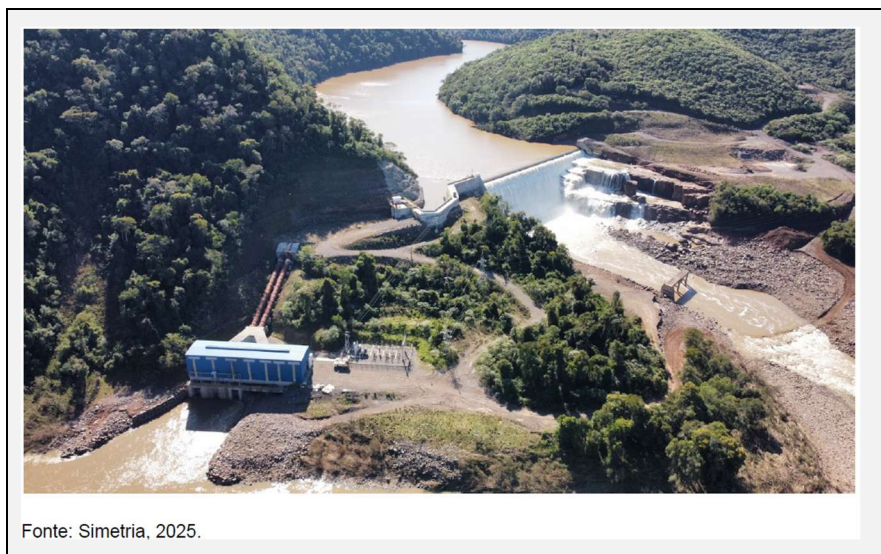
Figura 7 – Arranjo Geral - PCH Cachoeira Cinco Veados.
