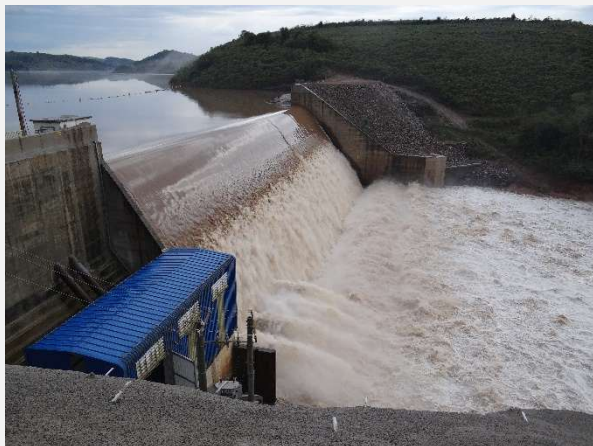
Vista de jusante da ombreira direita, vertedouro de soleira livre em vertimento e ombreira esquerda.
