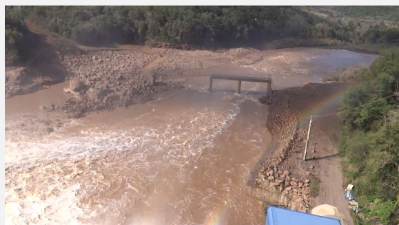
Acesso entre margem direita e esquerda por meio de ponte para pedestres temporária (pinguela).
