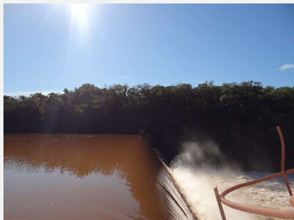
Barragem da PCH Quebra Dentes.
