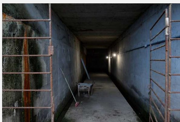
Galeria de Drenagem da Barragem da PCH Cachoeira Cinco Veados.
