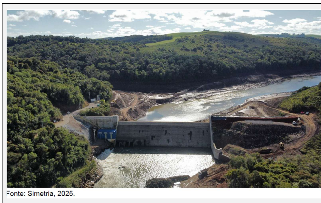
Figura 3 - Barramento da PCH Salto do Guassupi
