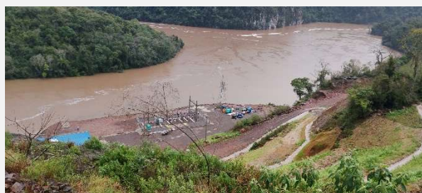
Vista da Casa de força e da Subestação Elétrica.
