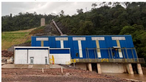
Figura 3 – Recuperação da casa de força principal
