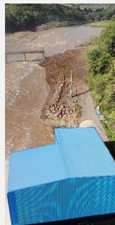
Jusante da Barragem da Cachoeira Cinco Veados.
